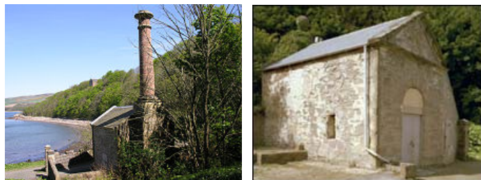
۳۷ و ۳۸) یک «گازسازی» قرن نوزده که تا ۱۹۴۷ استفاده می‌شد، در پارک قصرِ کولن Culzean، در اسکاتلند، با دودکشِ بازسازی شده در ۱۹۹۳؛ برای سطرِ ۱۹۰
